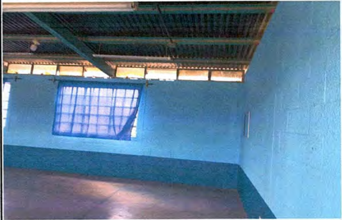
Foto 4: Aulas terminadas de pintar.
