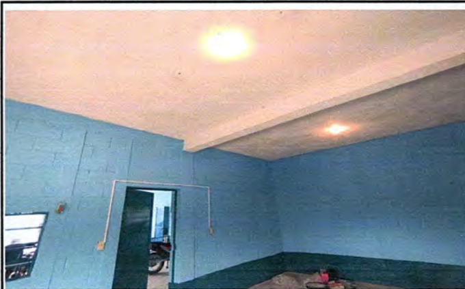
Foto 2: Instalación de energía eléctrica.
