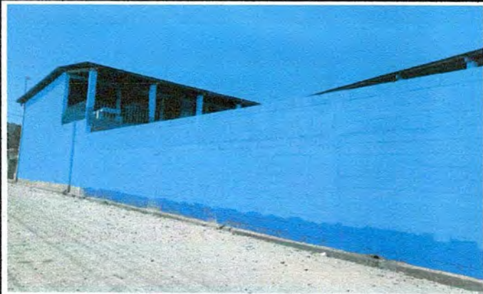
Foto 1: Finalización de la colocación de block.
