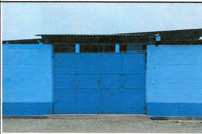
Foto 4: Colocación del portón nuevo del establecimiento.
