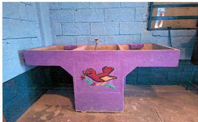
Foto 1: Instalación de pila y chorro
